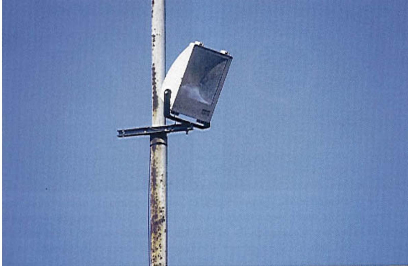
Figure 2.30: Il fascio di questo proiettore asimmetrico punta verso l'angolo superiore destro dell'immagine ma nell'area non vi è nulla che possa intercettare un fascio così angolato. Montaggio sbagliato o illuminamento volontario del cielo ?
