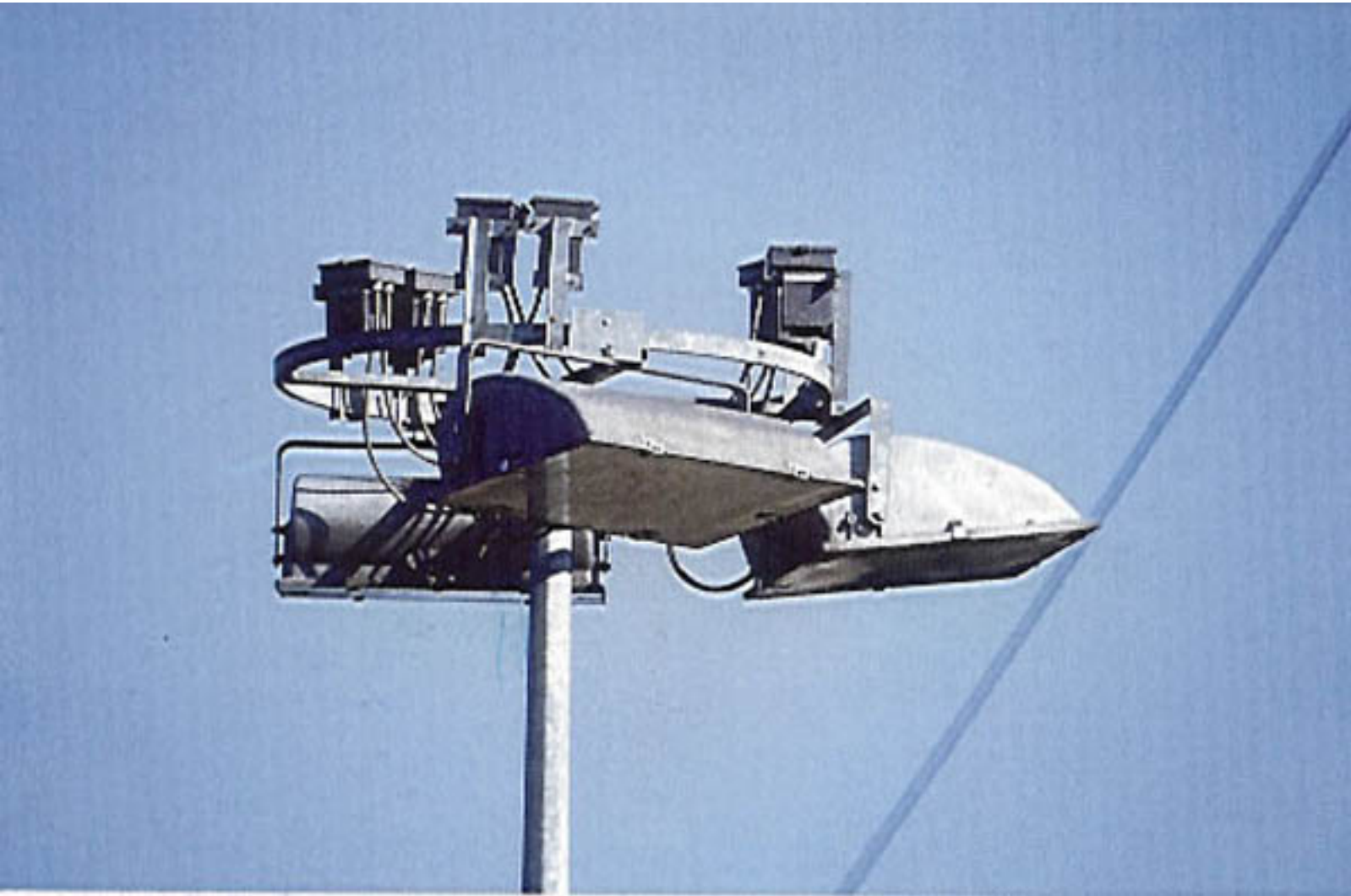
Figure 2.27: Illuminazione di aree ferroviarie senza dispersione di luce sopra il piano orizzontale. (Mestre-Venezia, area ferroviaria antistante Fincantieri)
