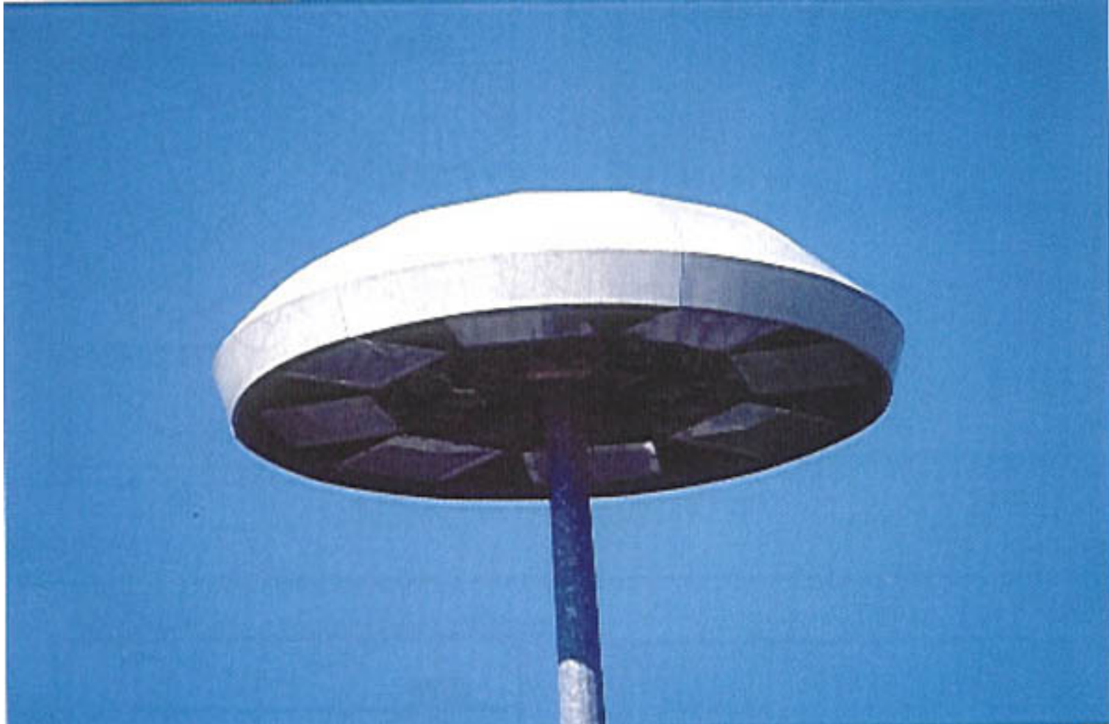
Figure 2.23: Illuminazione di grandi aree senza dispersione di luce sopra l'orizzonte: proiettori asimmetrici montati orizzontalmente e copertura superiore assicurano ad una torre faro una copertura perfetta. (Padova, C.so Australia)
