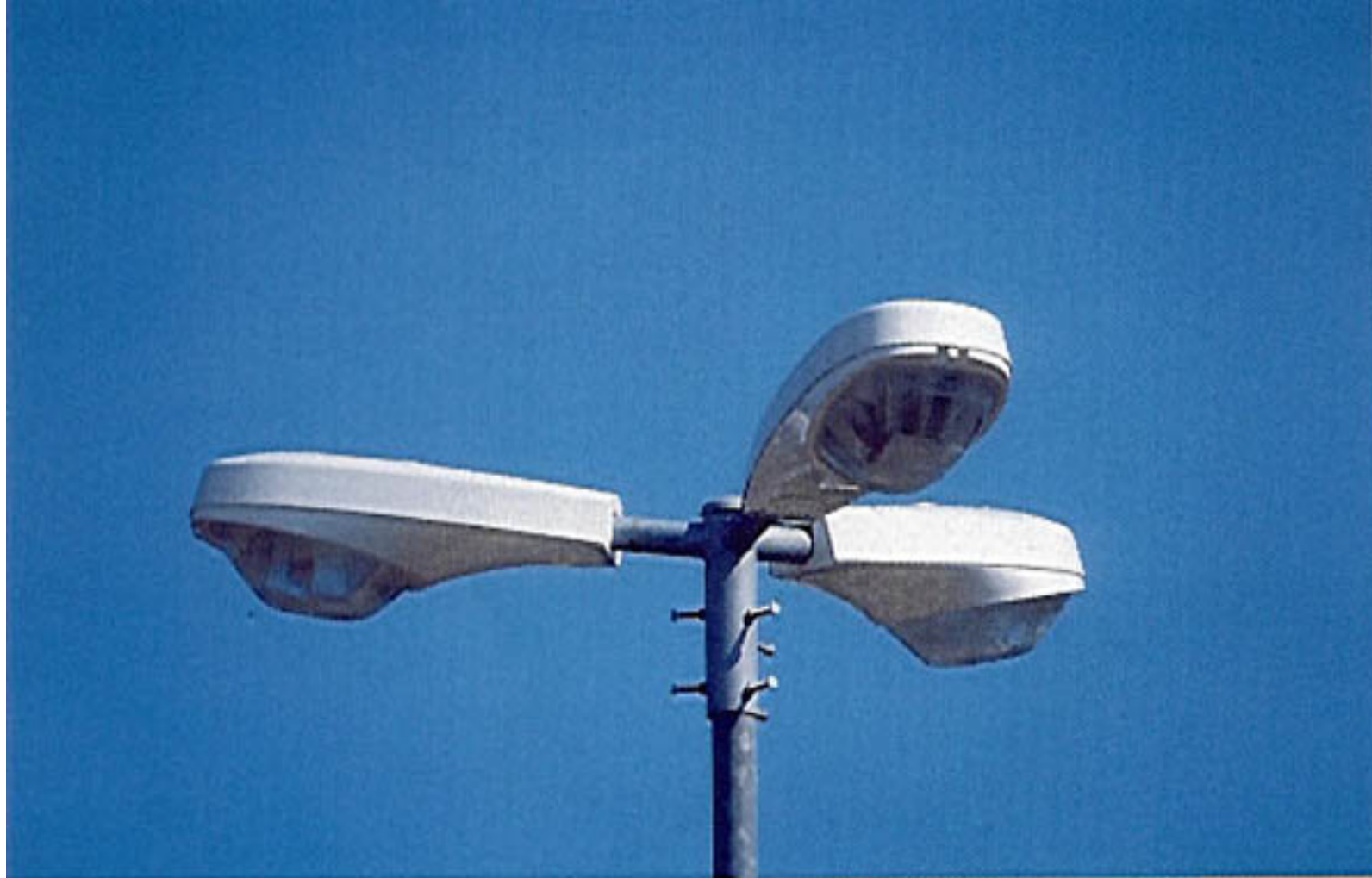
Figure 2.28: L'utilizzo di rifrattori prismatici sugli apparecchi utilizzati per l'illuminazione di ampie aree produce una notevole dispersione di luce sopra il piano orizzontale aumentata dall'inclinazione dell'ottica rispetto allo stesso piano. Per limitarla è necessario richiedere al fabbricante la chiusura con vetro piano (in genere disponibile). Se si desidera minimizzare completamente la quantità di luce emessa sopra l'orizzonte è necessario scegliere modelli installabili con l'ottica non inclinata.
