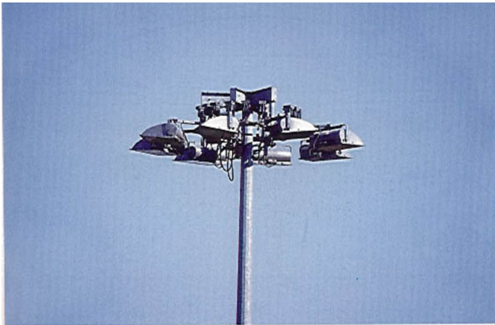
Figure 2.24: Anche senza copertura i proiettori asimmetrici assicurano una schermatura totale sopra il piano orizzontale se installati curando la loro perfetta orizzontalità. Troppo spesso questo viene tralasciato senza averne grandi vantaggi in termini di uniformità della luminanza. (Autostrada A4, Casello Padova Ovest)
