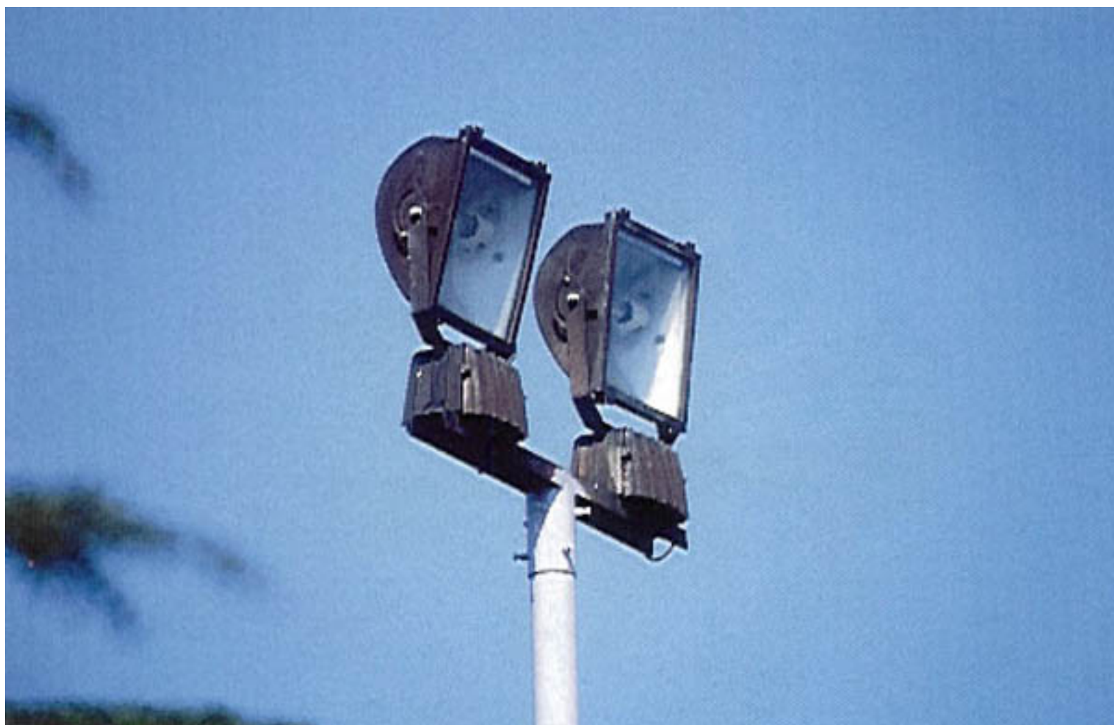
Figure 2.29: Il montaggio verticale anzichè orizzontale dei proiettori asimmetrici nell'illuminazione di piazzali e grandi aree produce un'elevatissima dispersione di luce sopra l'orizzonte ed è assolutamente da evitare.
