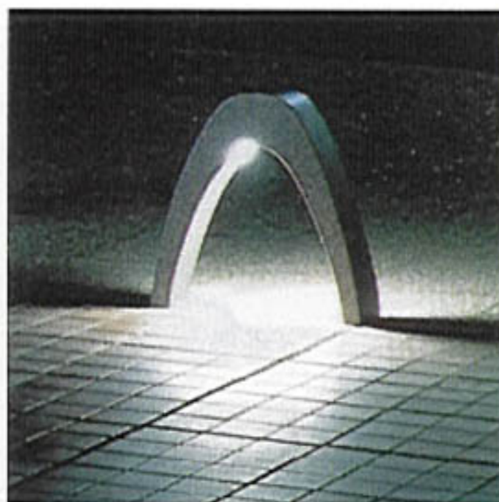
Figure 2.30: Il fascio di questo proiettore asimmetrico punta verso l'angolo superiore destro dell'immagine ma nell'area non vi è nulla che possa intercettare un fascio così angolato. Montaggio sbagliato o illuminamento volontario del cielo ?
